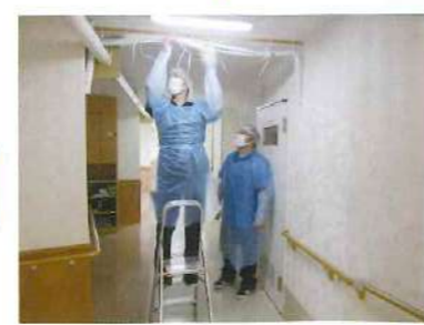
感染拡大を防ぐため、ゾーニングの仕切を設置
